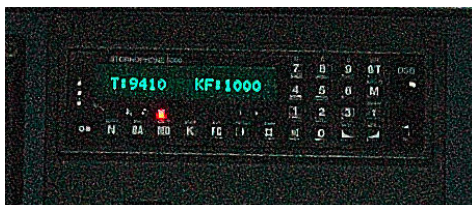
Betjeningspanel til S-baneradio i førerrum i litra SA
